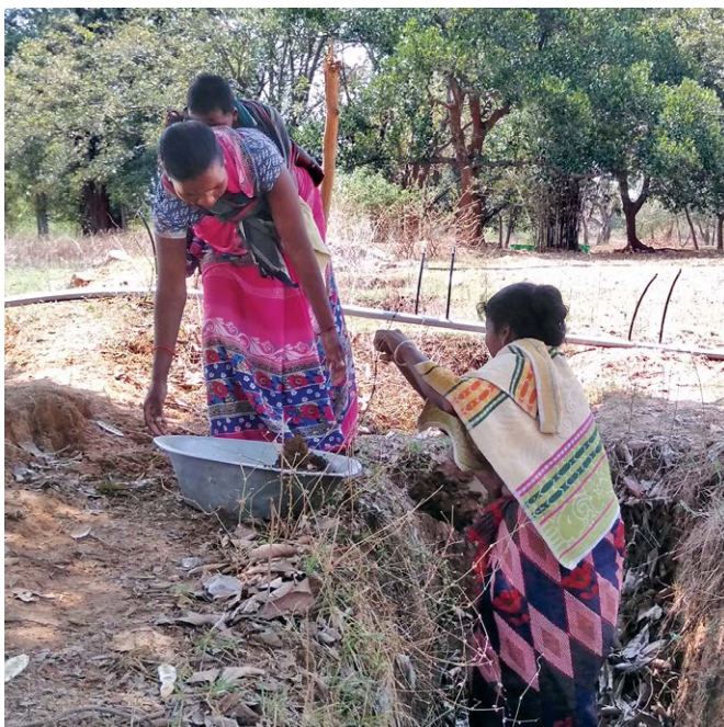
^ In den neu angelegten Gräben kann sich das Regenwasser für die Bewässerung stauen.
